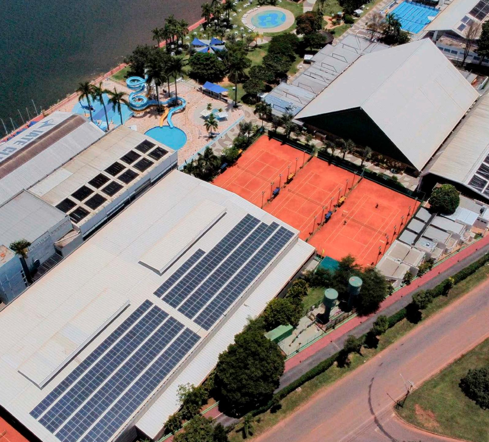
A estrutura do Clube ainda conta com coletores solares. Esses equipamentos garantem o aquecimento das duas piscinas semiolímpicas, a do Toboágua e a da Baleia. Além disso, proporcionam água quente para o banho dos sócios. Com isso, o Iate não utiliza mais chuveiros elétricos, considerados muitas vezes os vilões da conta de luz.
