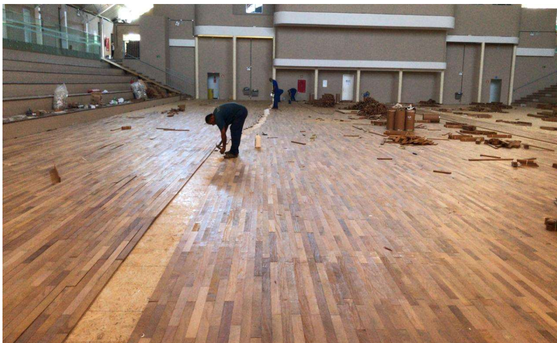
execução novo piso
