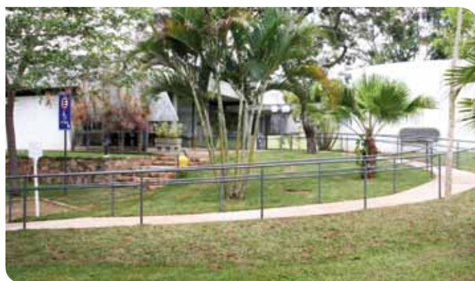
Rampa para portadores de necessidades especiais
